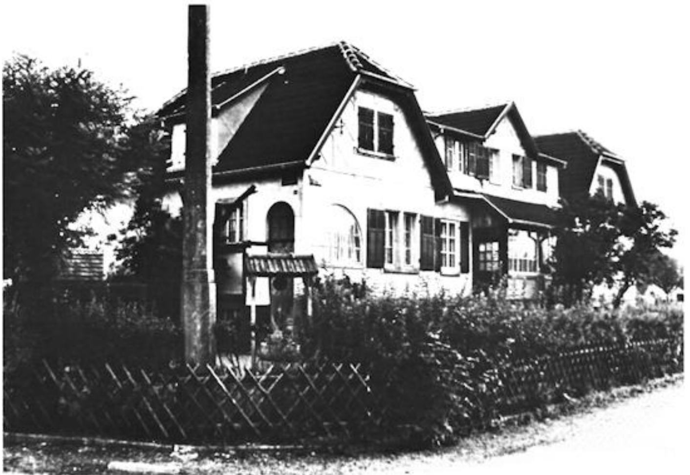
3. Villages ouvriers des Mines de Potasse d'Alsace : Staffelfesden. Maison à quatre logements d'inspiration alsacienne
